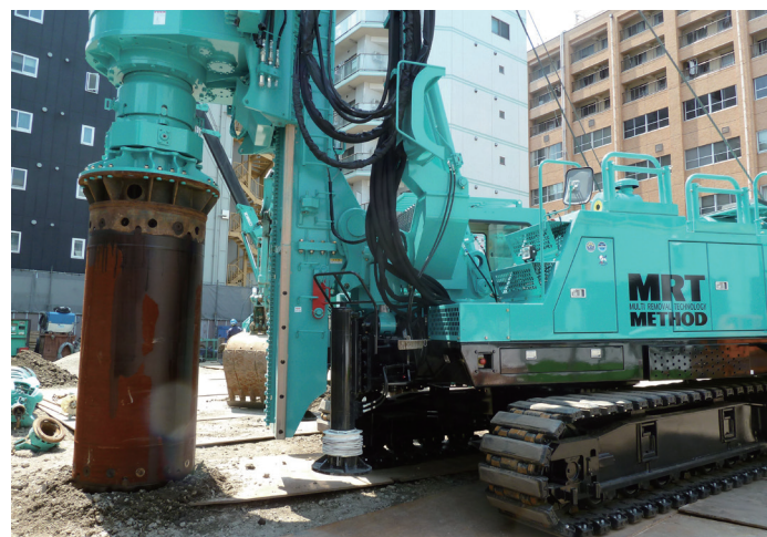
■ ケーシング掘削状況
