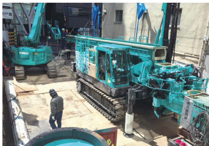
■ 狭隘地施工状況
